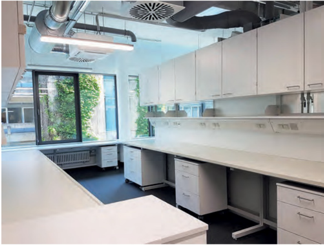
Bild 3. Molekularbiologisches Labor im S2-Bereich: Medienversorgung und Einrichtung sind flexibel geplant, damit sie aktuellen Anforderungen und zukünftigen Nutzungsänderungen gerecht werden können.
