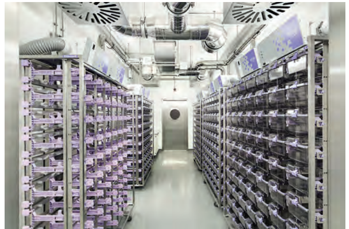
Bild 5. Niedersächsisches Zentrum für Biomedizintechnik, Implantatforschung und Entwicklung (NIFE), Hannover: Haltungsräume für Mäuse mit IVC-Käfigsystemen
