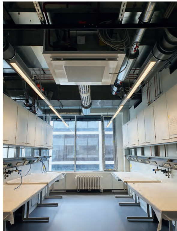
Bild 1. Universitätsklinikum Freiburg – IMITATE: Blick in eines der molekularbiologischen Labore kurz vor der Fertigstellung
