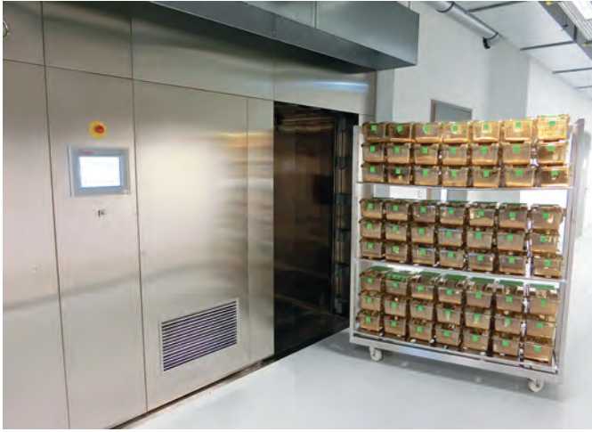
Bild 7. Center for Integrative Physiology and Molecular Medicine (CIPMM), Universität des Saarlandes, Campus Homburg: befahrbare Großraumautoklaven als Barriere zum eigentlichen Tierhaltungsbereich
